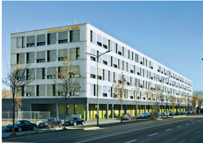
Stacked industrial - Concrete frame Gewerberhof Laim, Munich, Bogevischs Buero
